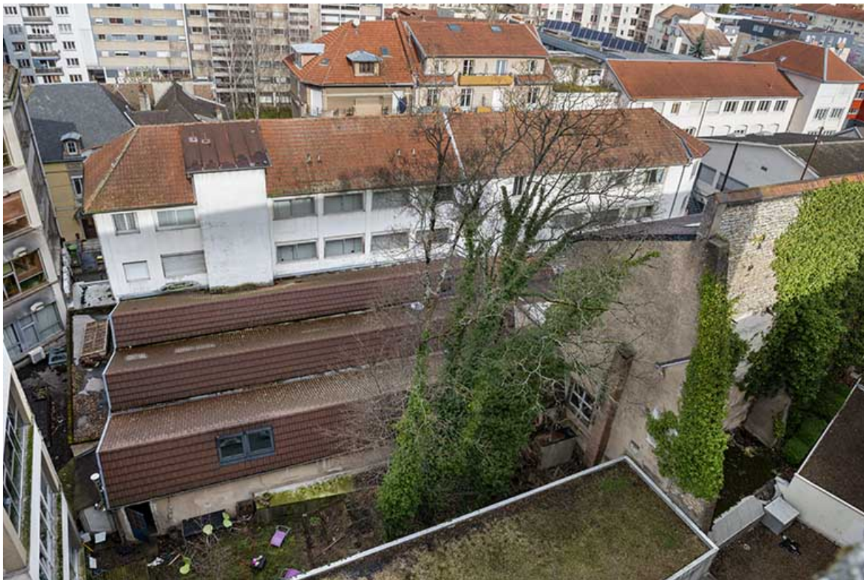
Vue plongeante depuis le sud.
