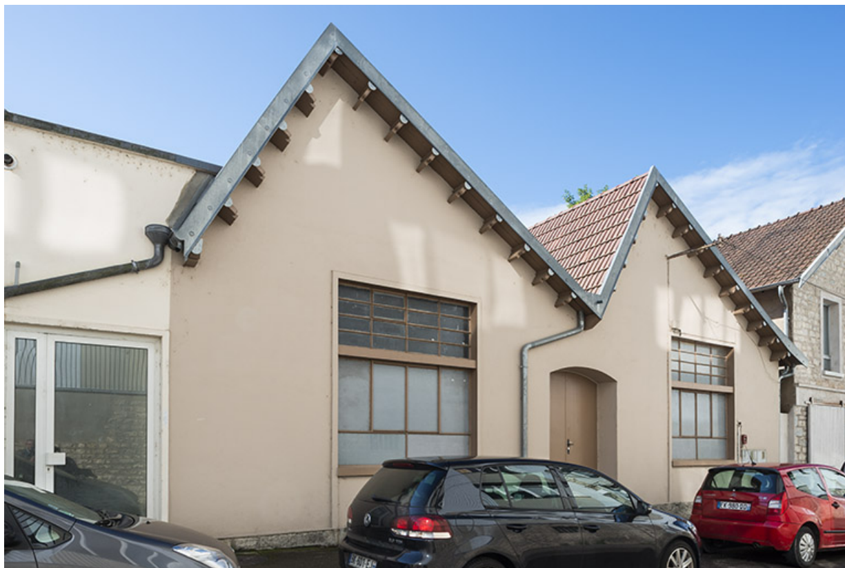
Murs-pignons des sheds sur le rue Klein.
