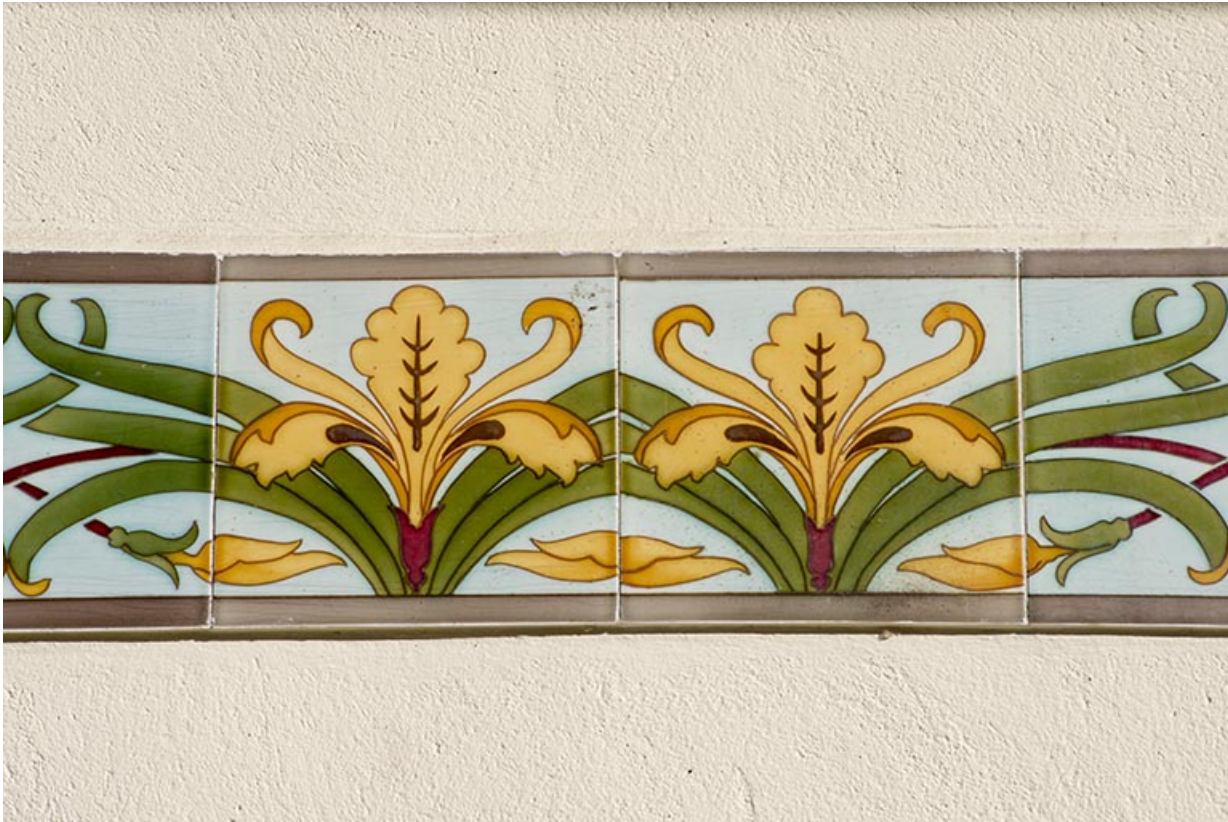
Pignon est de l'atelier. Détail des faïences.
