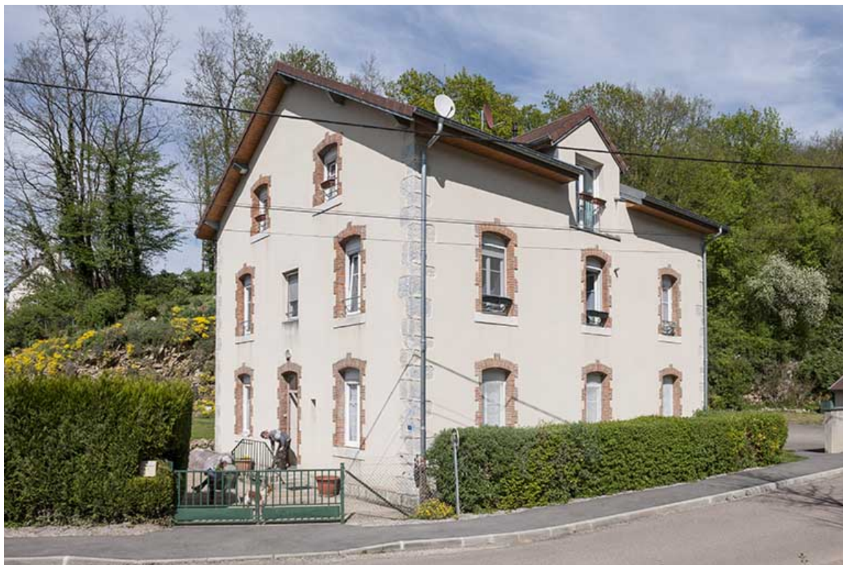
Logement (ou bureau ?) à l'entrée du site.
