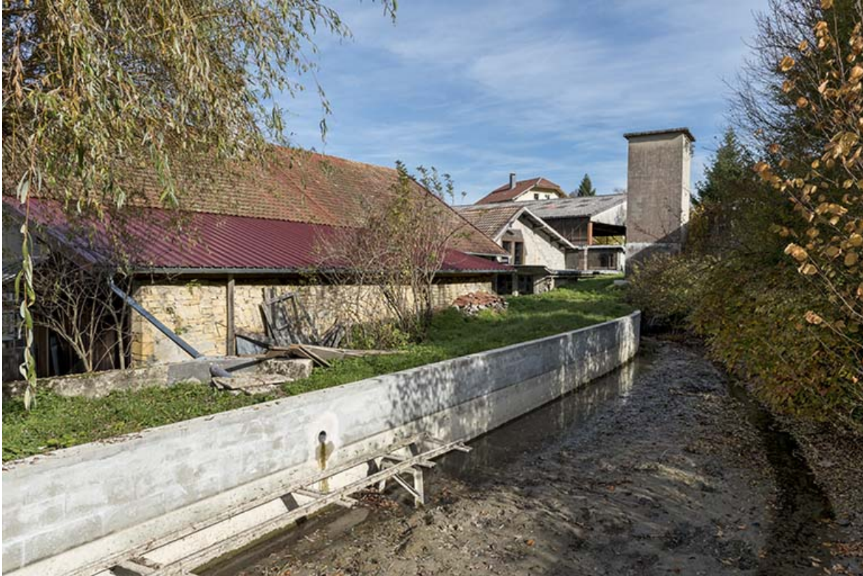
Bâtiment ancien : façade postérieure et canal d'amenée.
