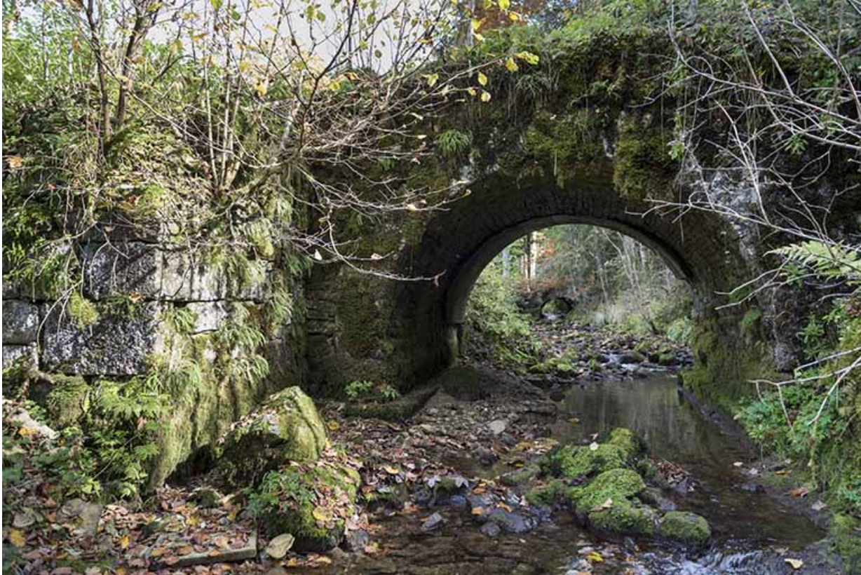
Pont en aval, à l'ouest.
