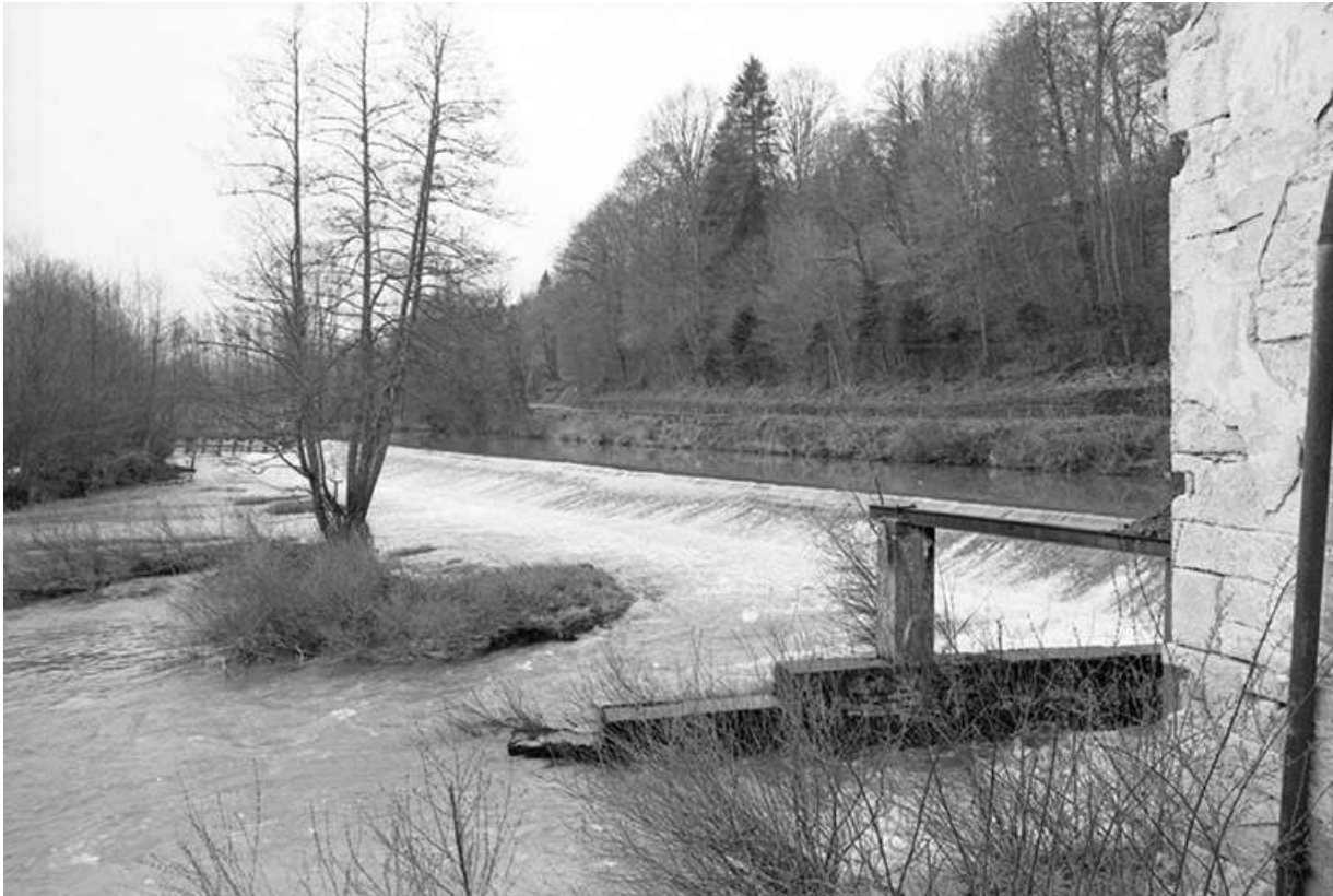
Vue du barrage.
