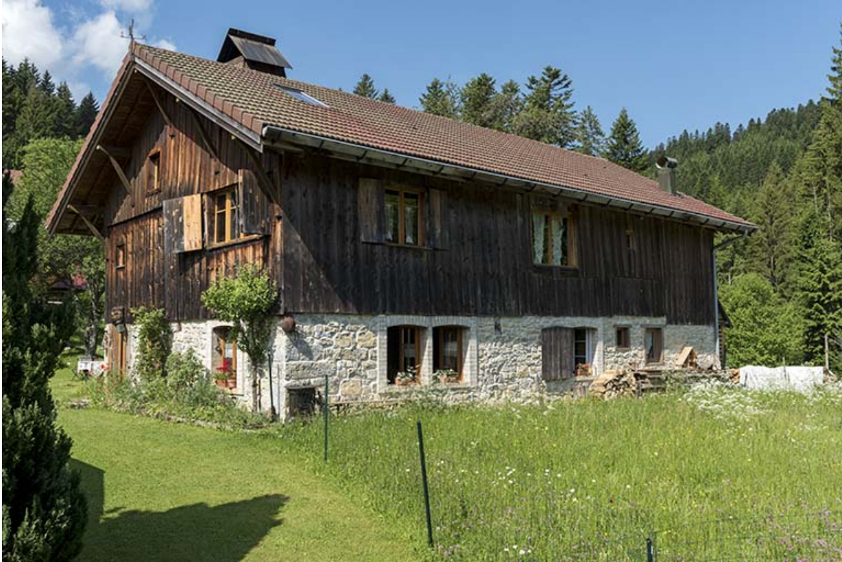
Façades antérieure et latérale droite.
