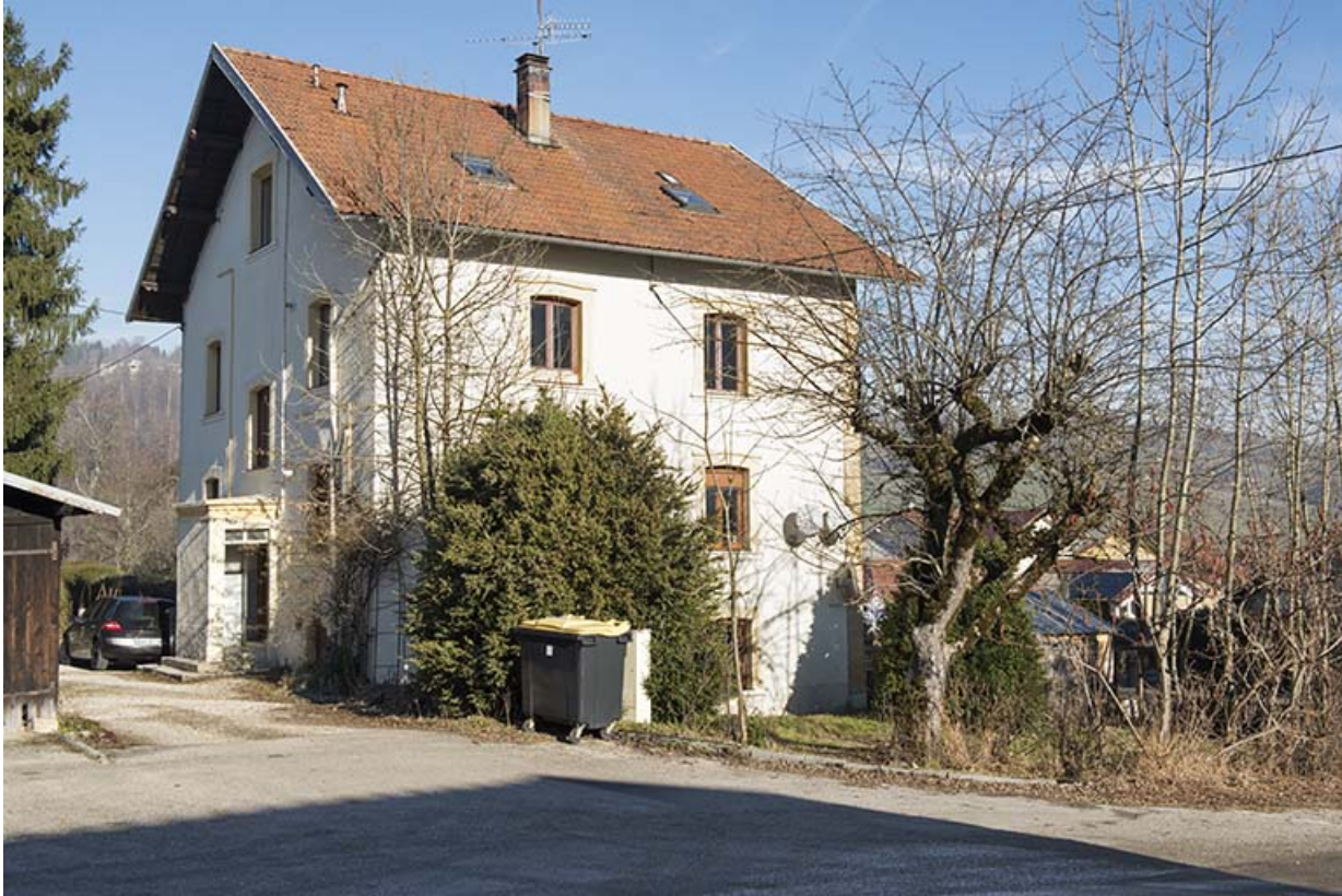
Façades postérieure et latérale gauche.
