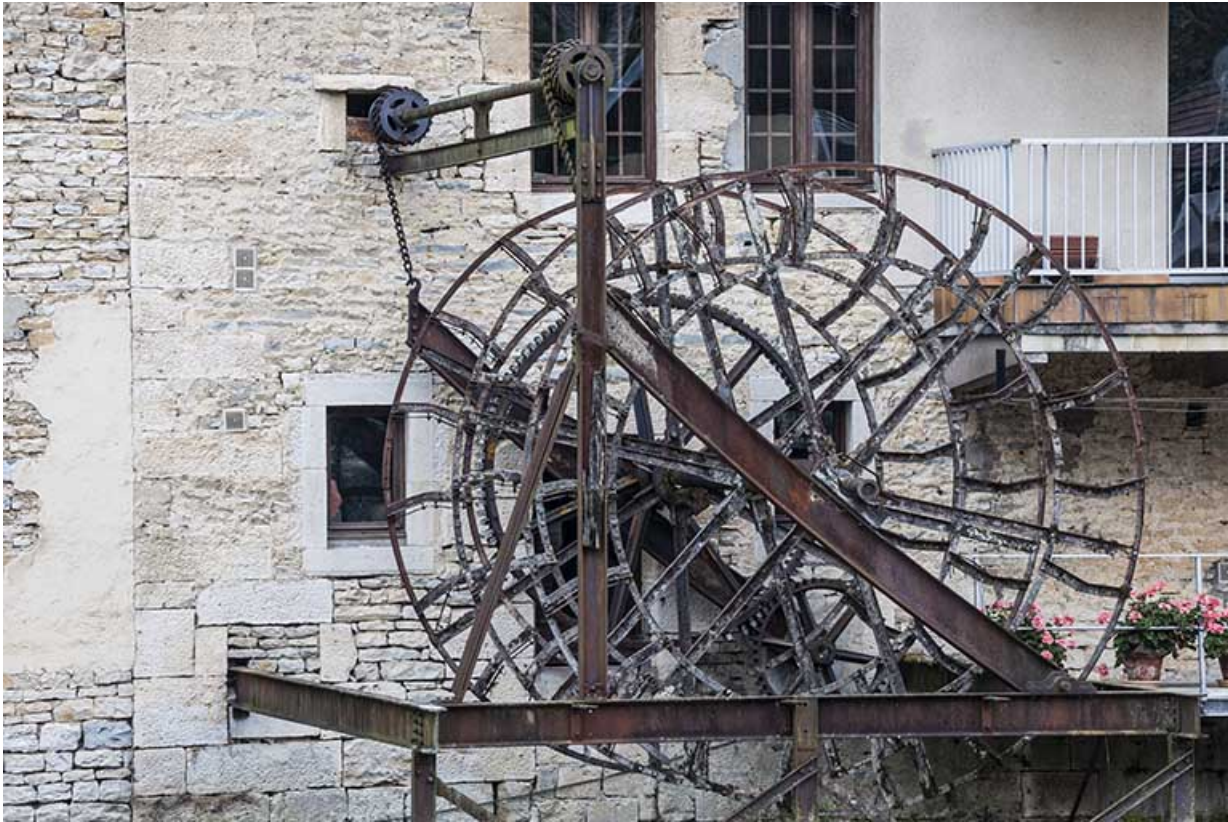
Détail de la la roue pendante.
