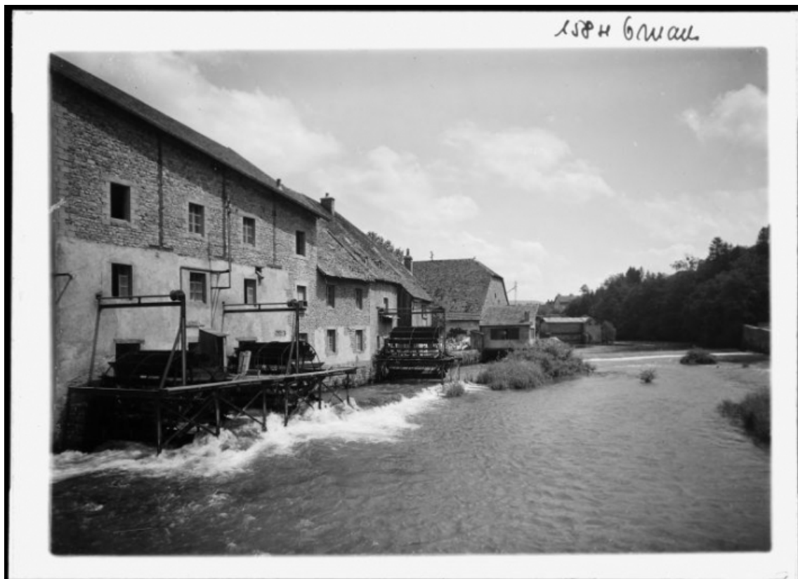
[Vue depuis l'aval], s.d. [vers 1930].
