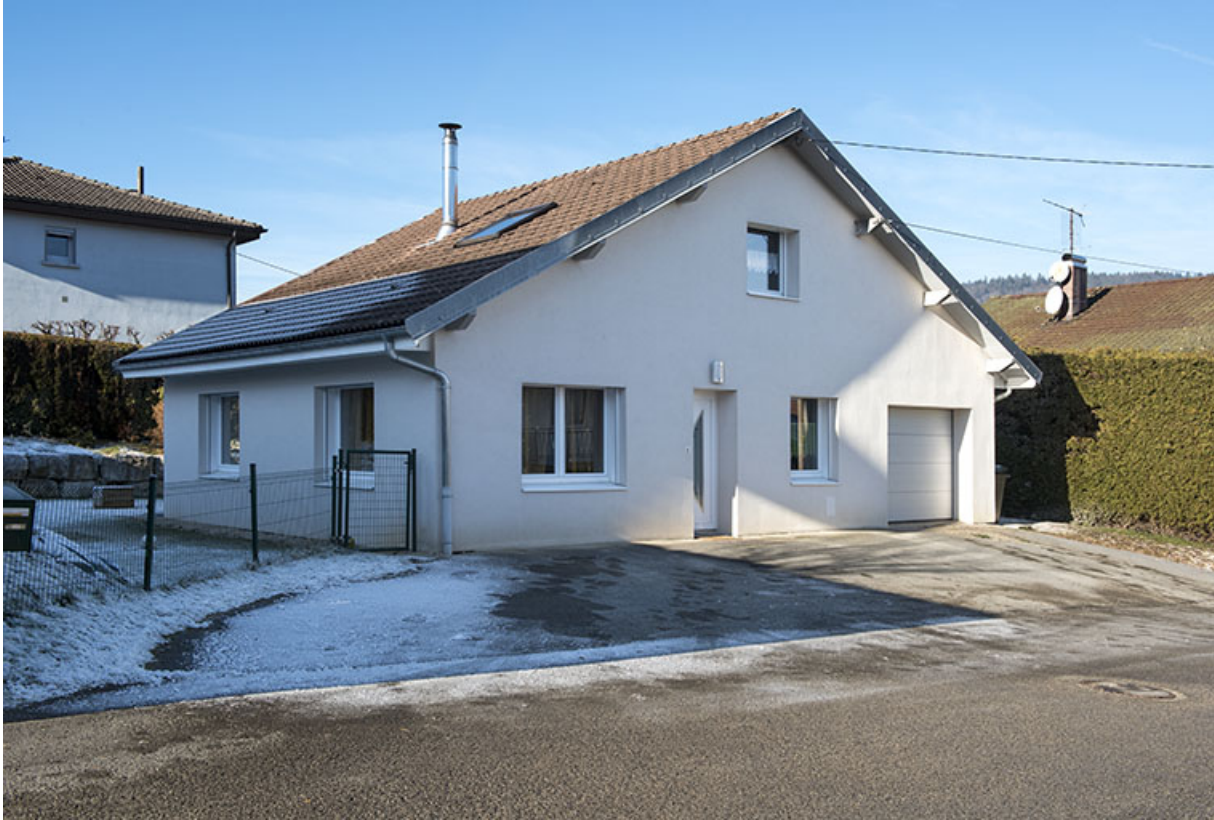
Façades antérieure et latérale gauche.
