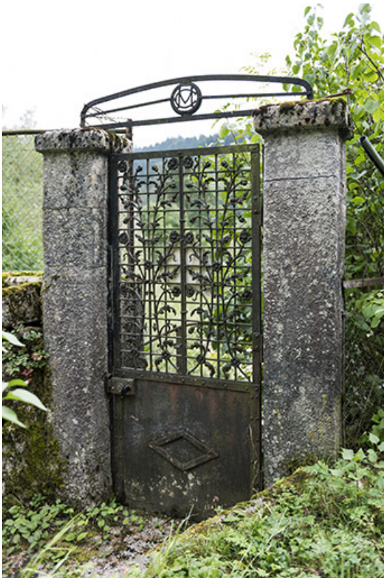
Porte de la clôture, au sud-est.
