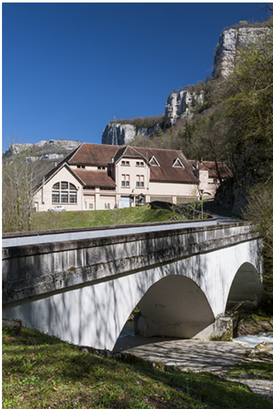
Vue du bâtiment d'exploitation depuis la centrale.
