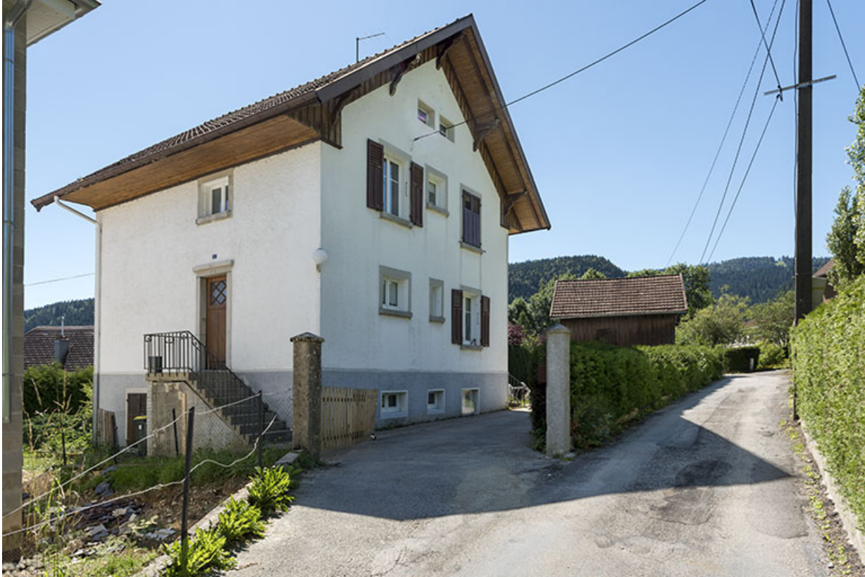
Maison : façades antérieure et latérale gauche.
