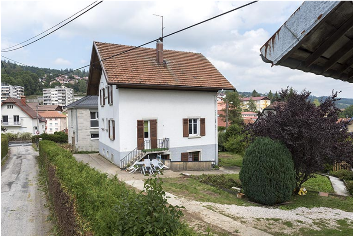
Maison : façades antérieure et latérale droite.
