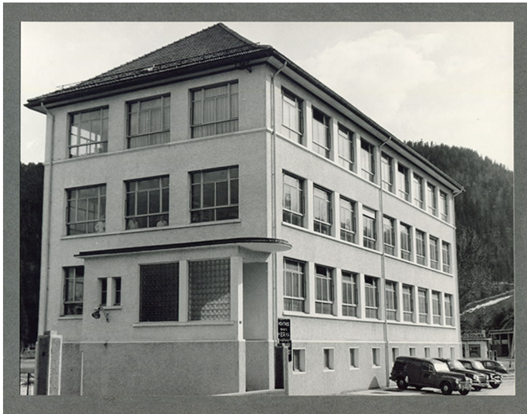
Façades antérieure et latérale gauche, années 1960.
