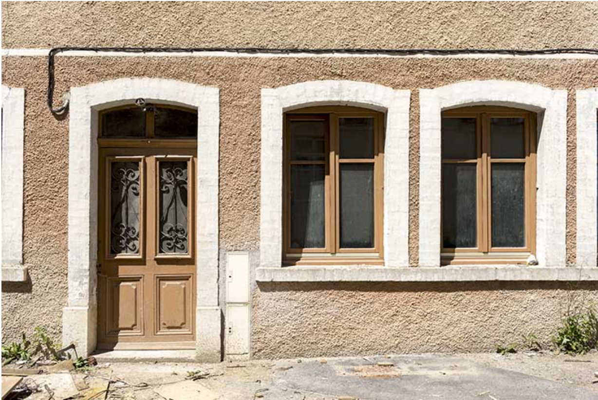
Façade postérieure : porte et fenêtres multiples.
