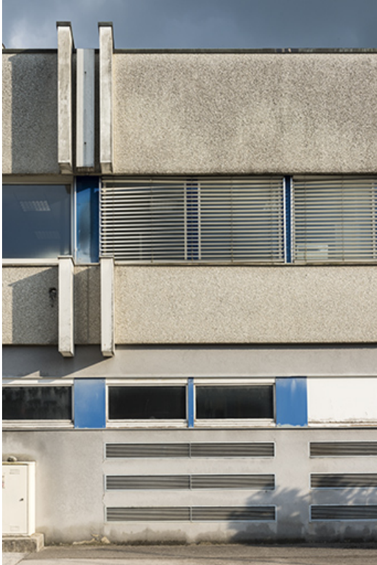
Façade ouest : une travée de l'atelier de 1970.
