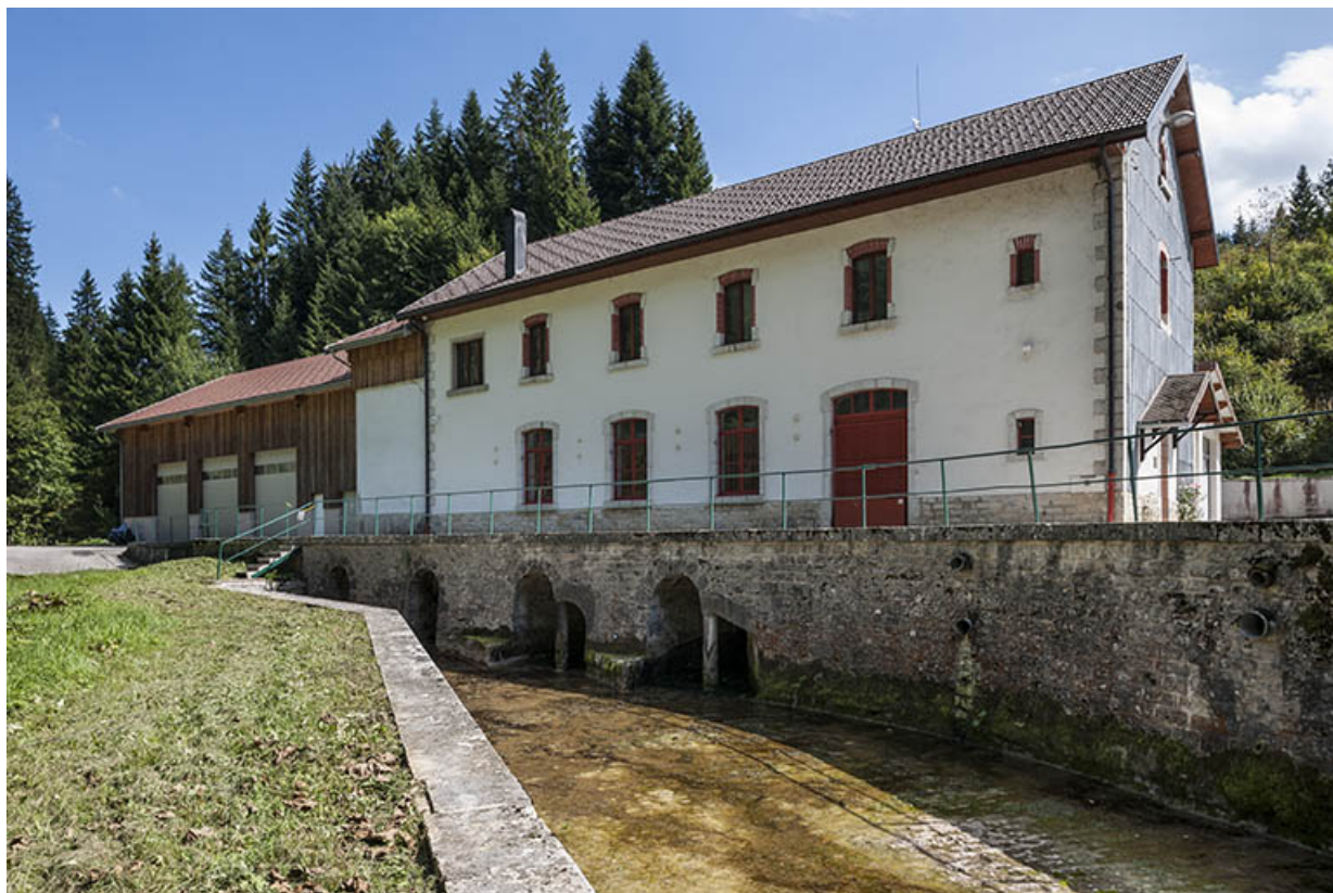
La centrale et le canal de fuite.
