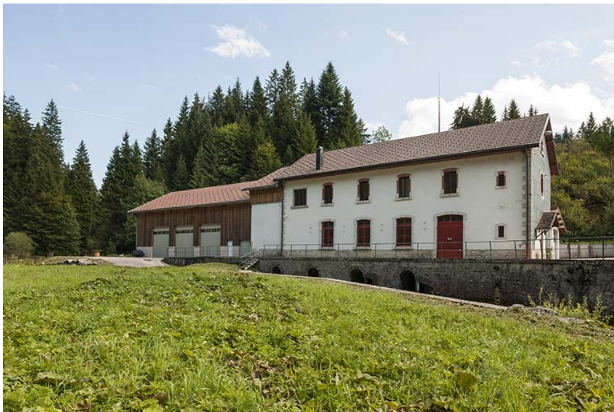
Façade nord vue de trois quarts.
