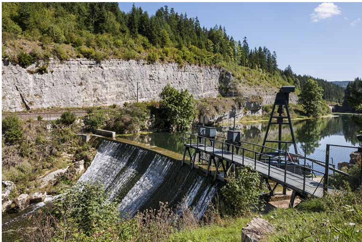
Le barrage depuis la rive gauche.
