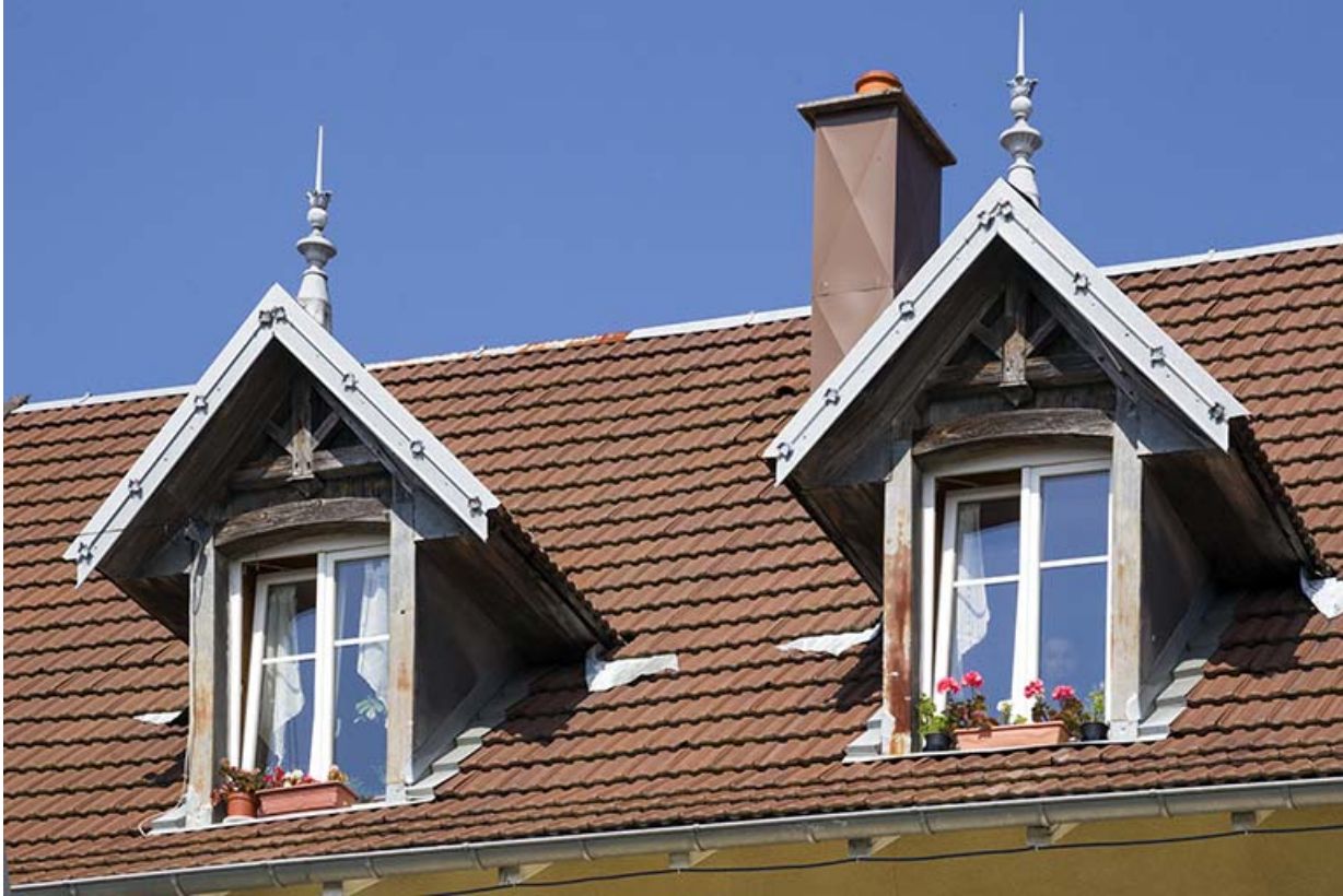
Logement patronal, façade latérale gauche : lucarnes.
