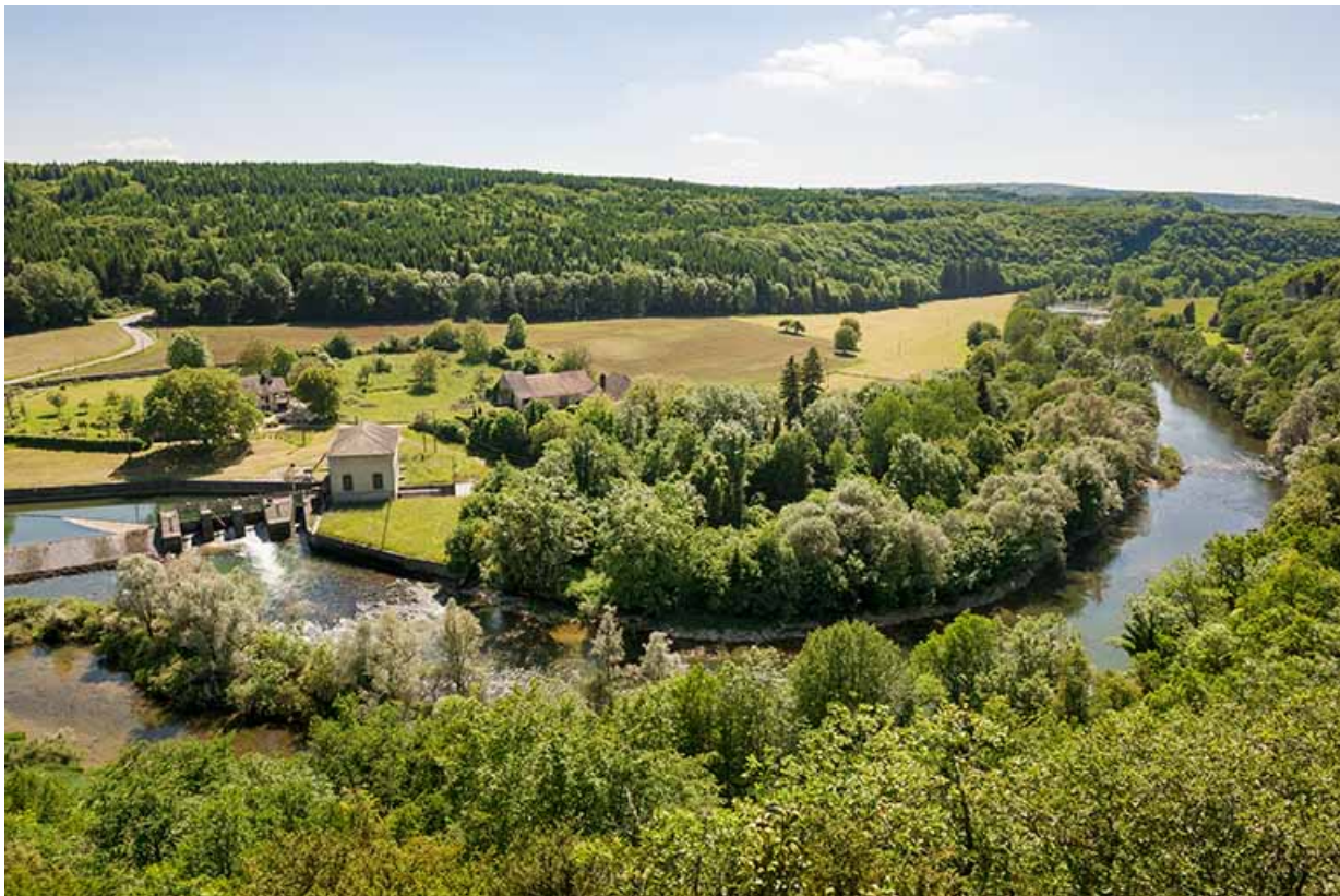
Vue plongeante d'ensemble depuis le nord-est.
