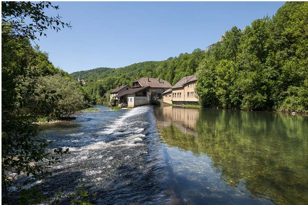
Vue d'ensemble depuis le barrage, en amont.
