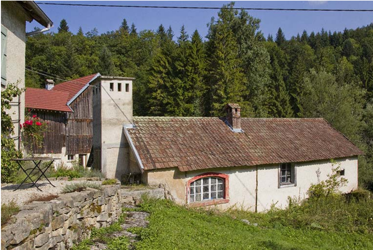
Centrale : façade postérieure, de trois quarts gauche.
