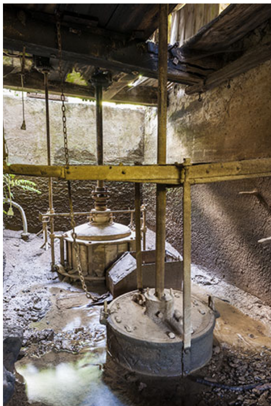
La chambre d'eau des turbines.
