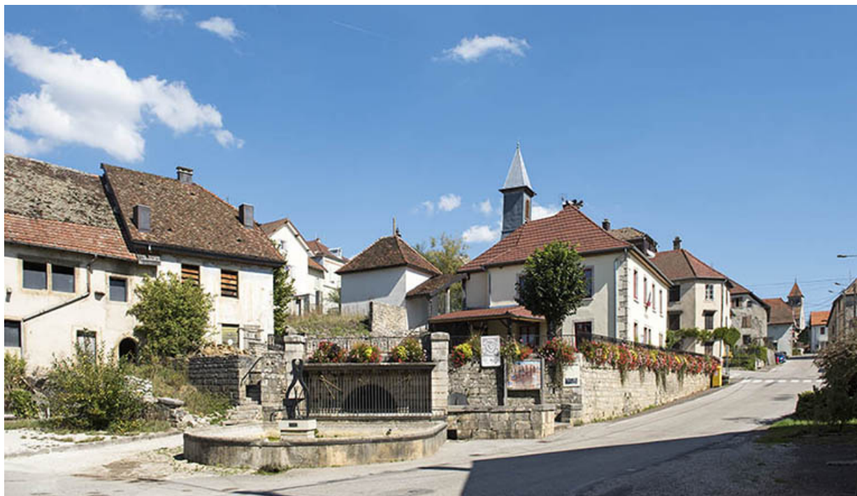
La Grande Rue, à Montécheroux.
