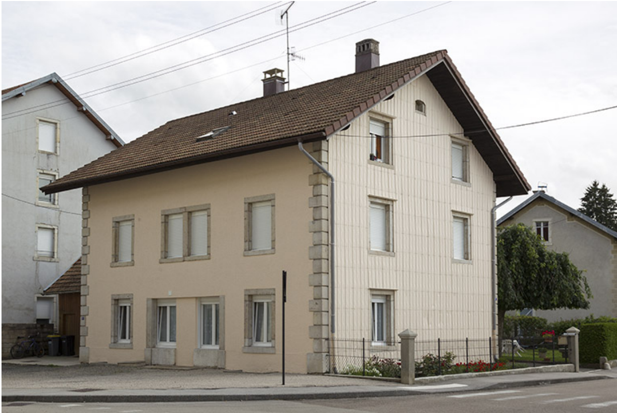
Façades antérieure et latérale droite.
