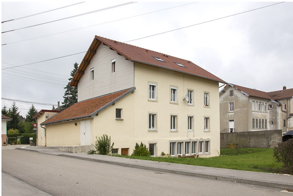
Façades postérieure et latérale gauche.
