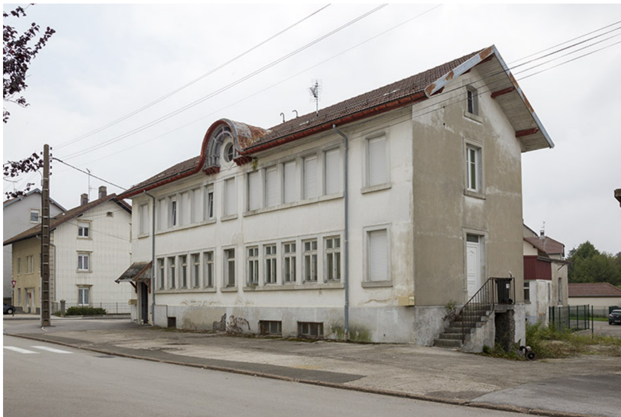
Façades antérieure et latérale droite.
