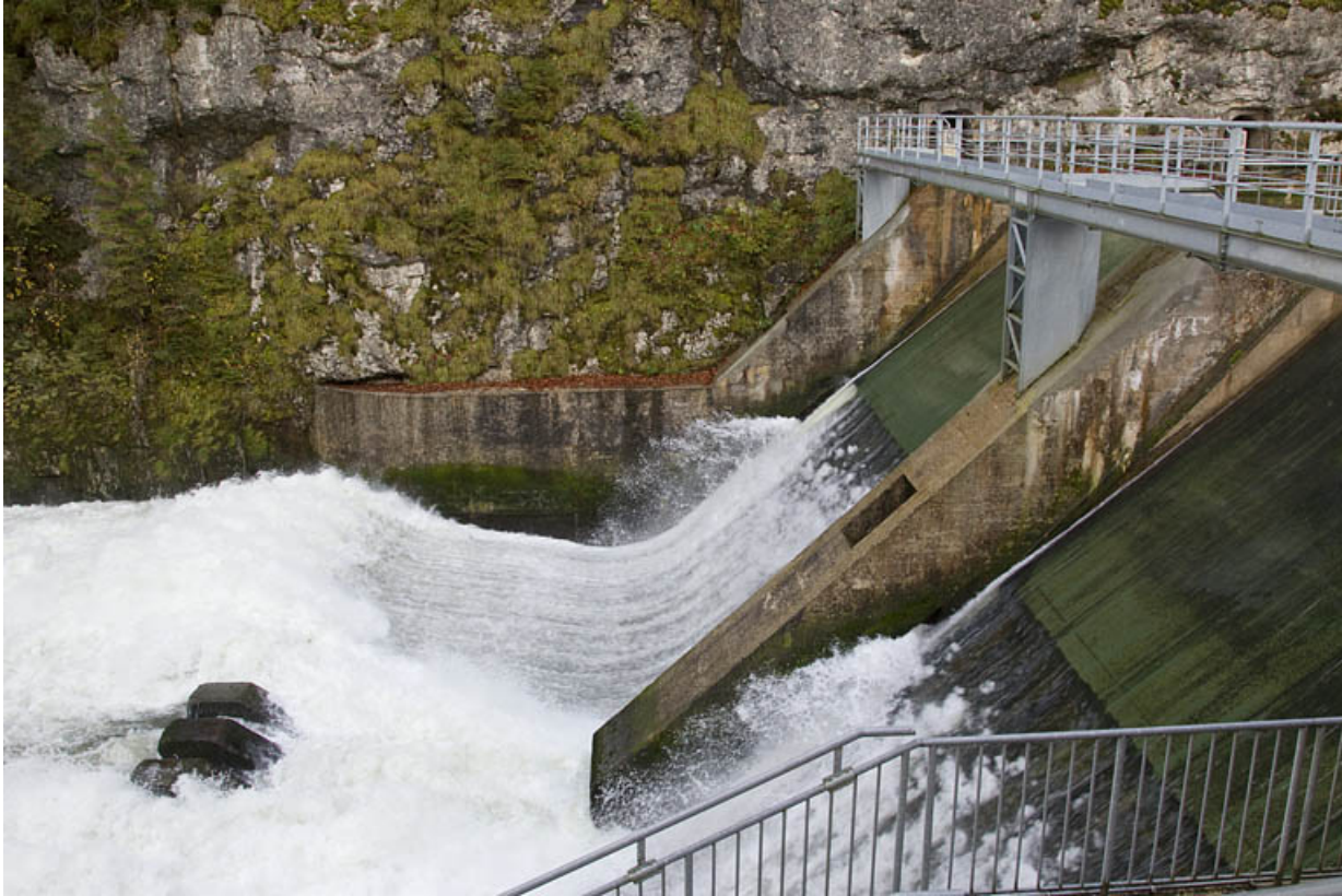
Barrage : vue plongeante sur les vannes toit.
