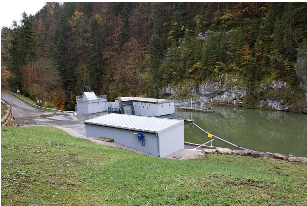
Vue d'ensemble depuis le nord-ouest (amont).
