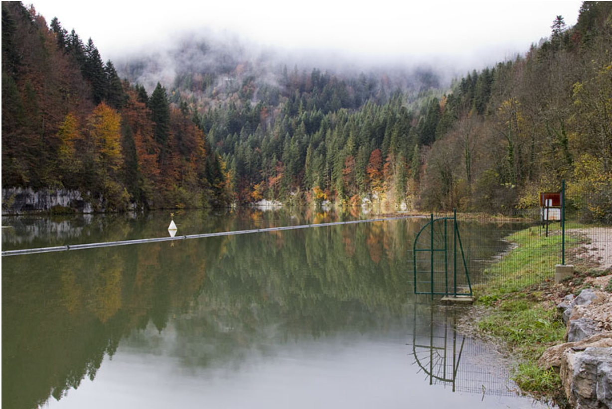
Le bassin de retenue, depuis le nord-est.
