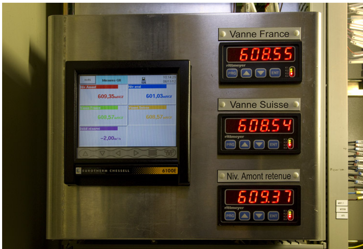
Barrage : cadran numérique de contrôle du fonctionnement des vannes et du niveau de la retenue.
