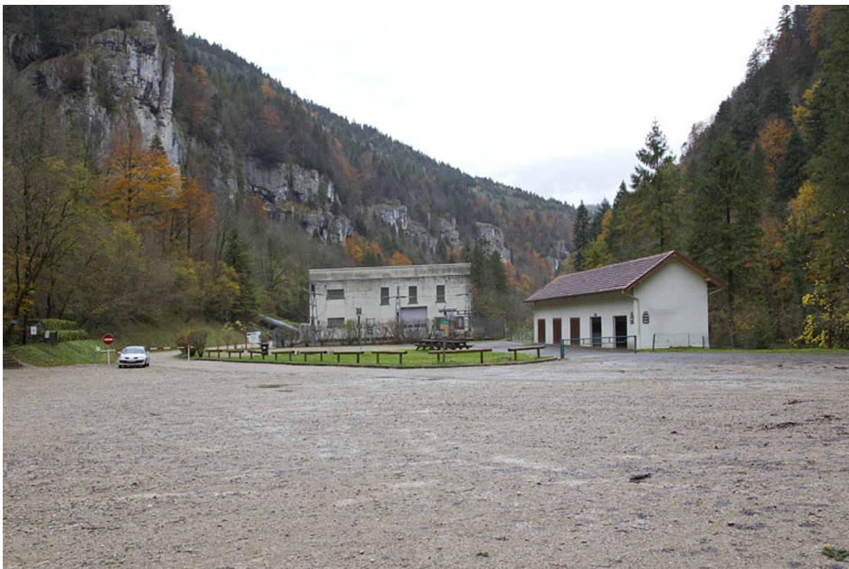
Vue d'ensemble, depuis le sud (amont).
