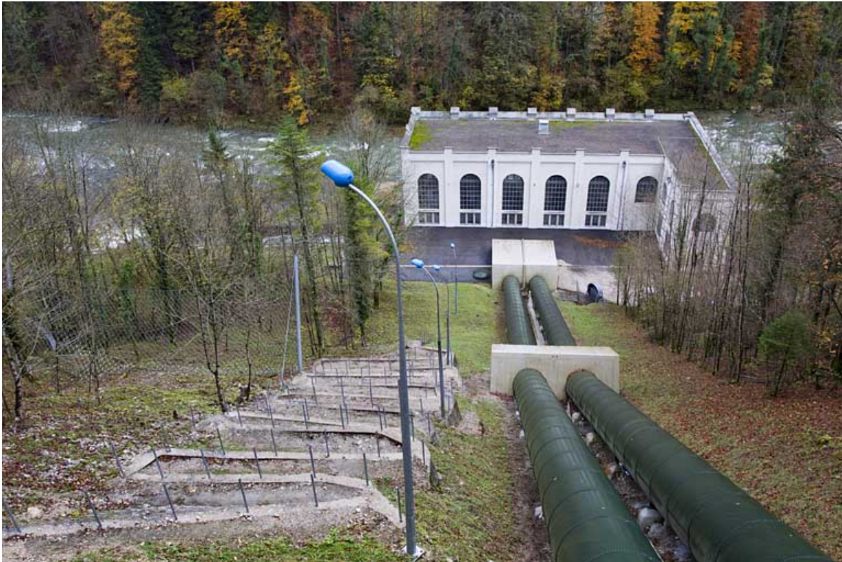
Centrale : vue plongeante depuis l'ouest.
