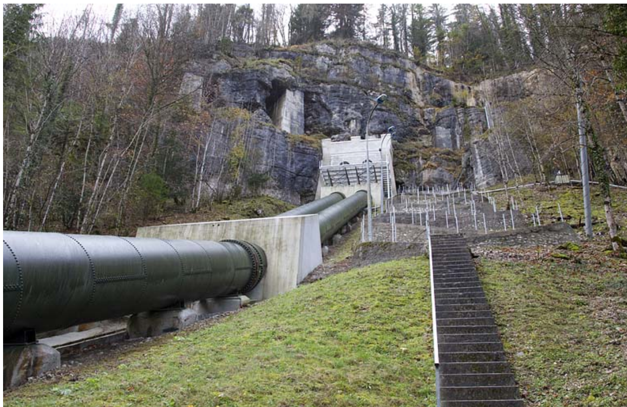
Conduite forcée : chambre de mise en charge et conduite depuis la centrale, vues de trois quarts.
