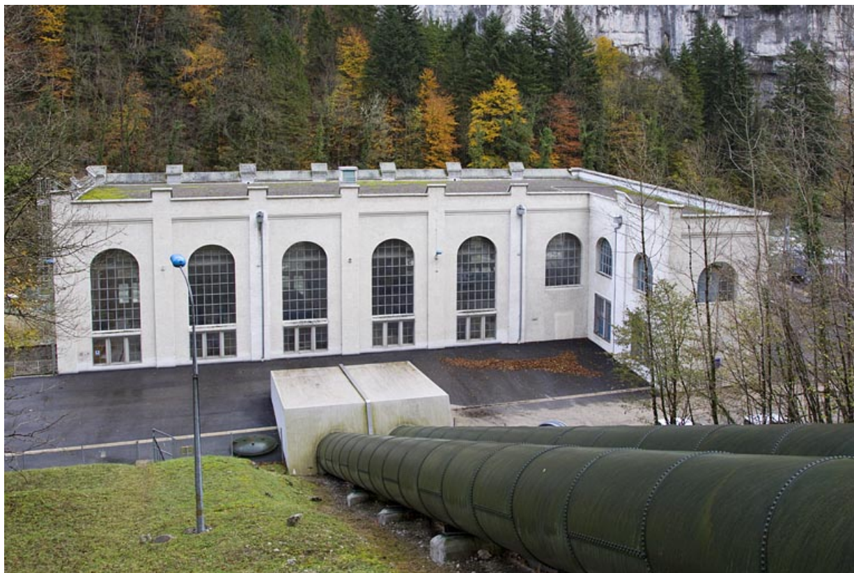
Centrale : façade latérale droite (élévation orientale).
