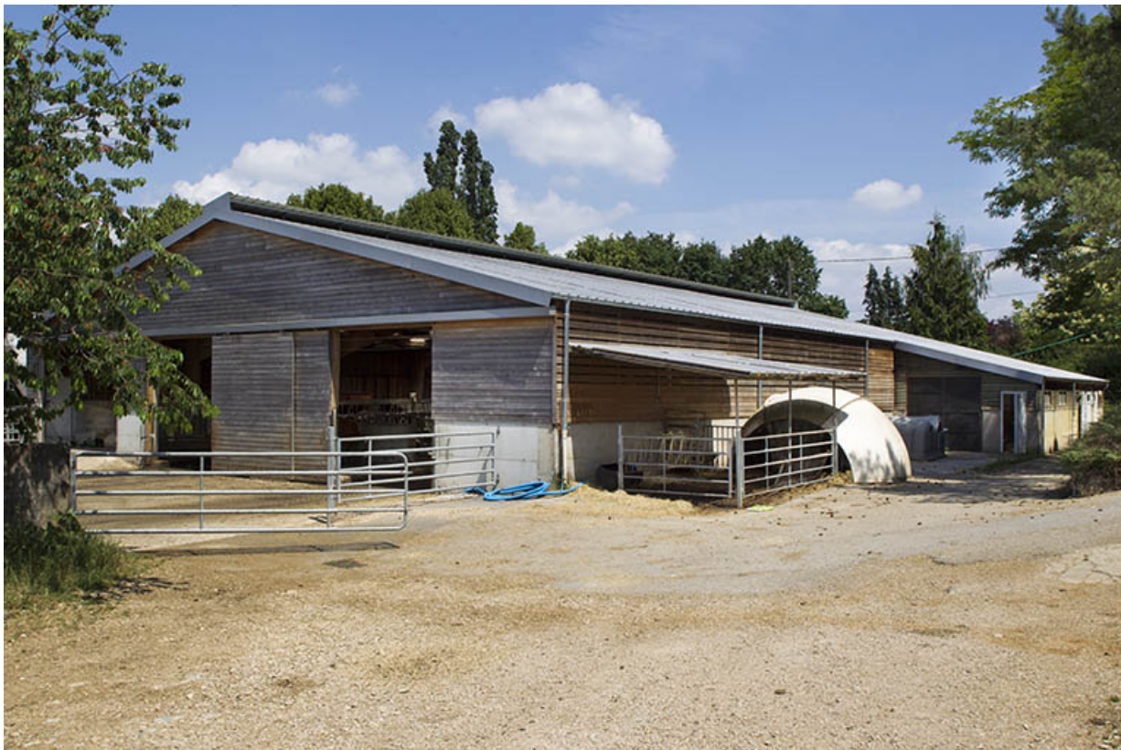
L'étable ouest vue de trois-quart sud-est.
