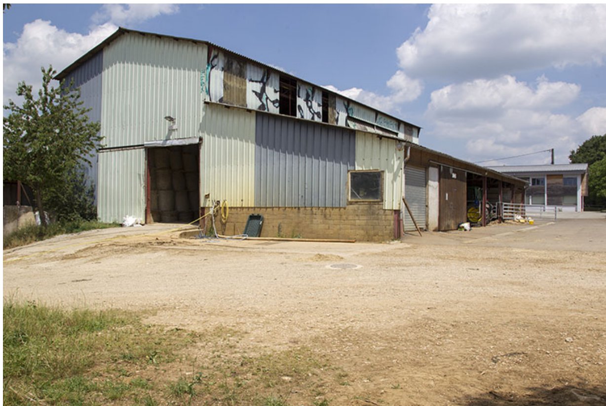
Vue de trois-quart sud-est de l'entrepôt agricole.
