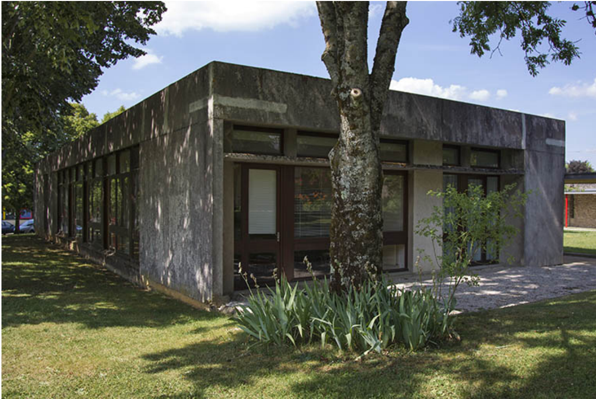
Angle sud-ouest de l'administration.
