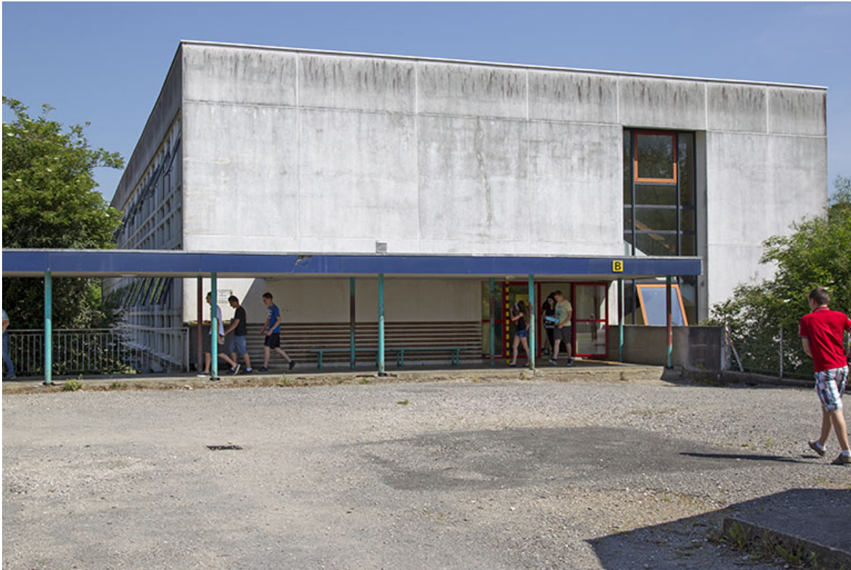
Pignon sud de l'externat.
