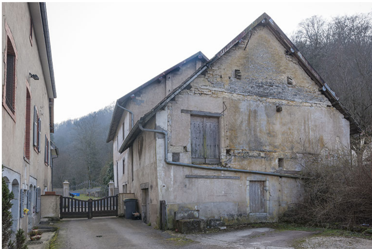
Façade est et pignon nord.
