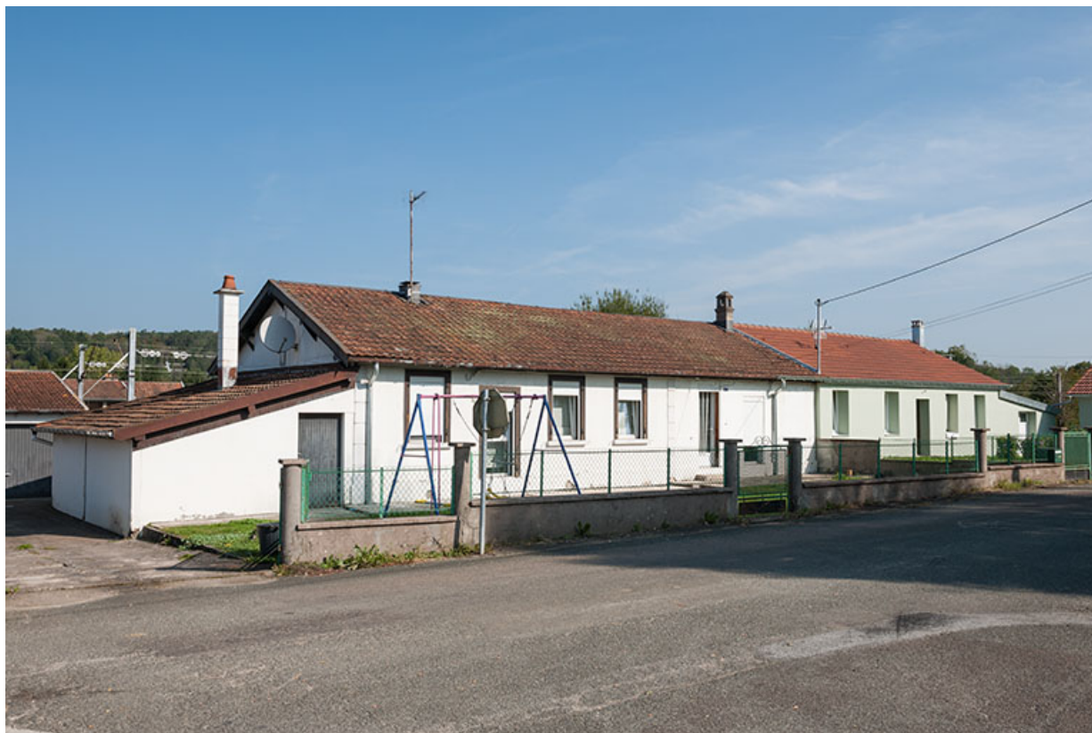
Habitation en rez-de-chaussée (3 logements).
