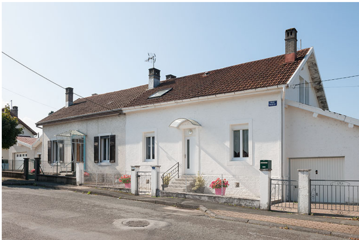
Maison jumelée vue de trois quarts droite.
