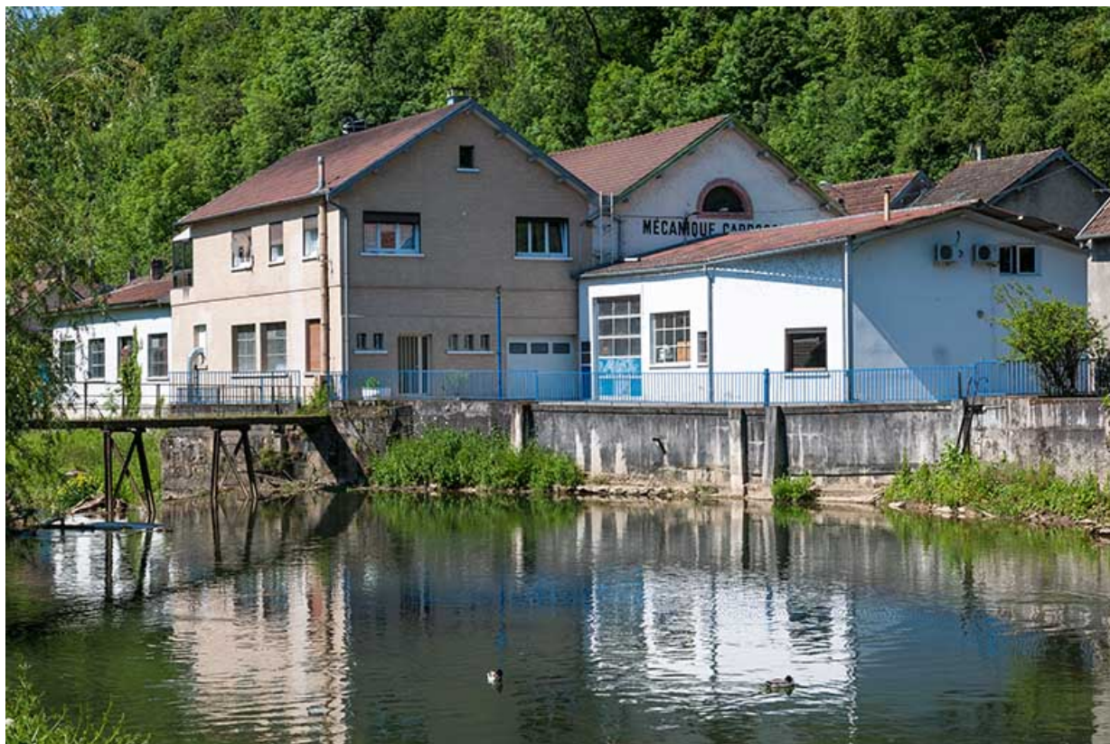
Vue du pont, depuis l'amont.
