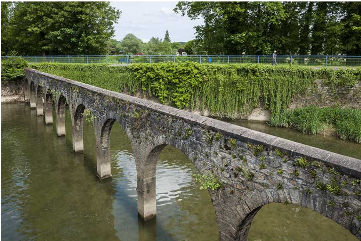
Arcades enjambant l'ancien canal de fuite.
