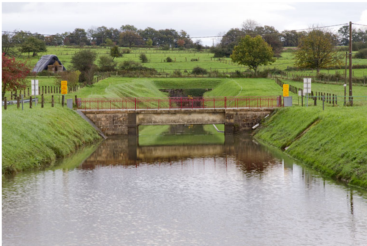
Pont routier sur le bief d'amenée.
