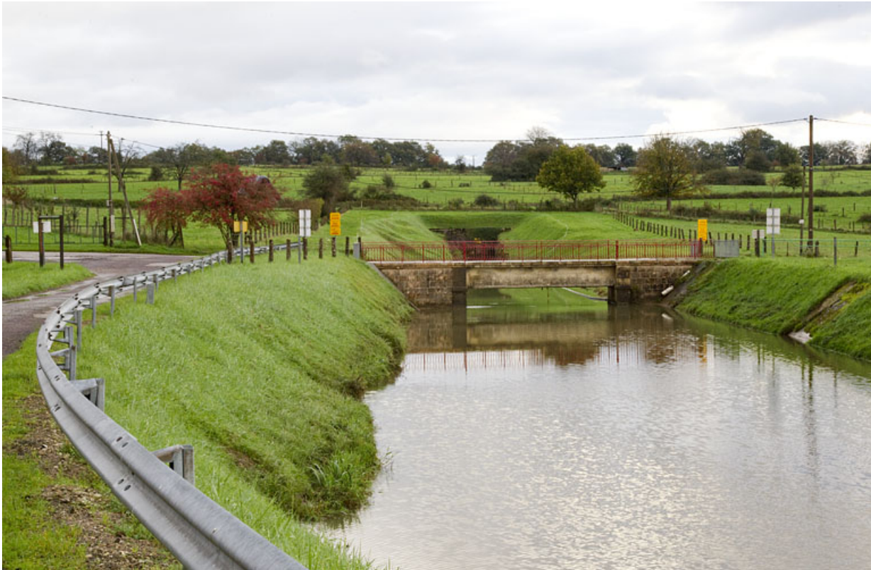
Bief d'amenée à la sortie du tunnel.
