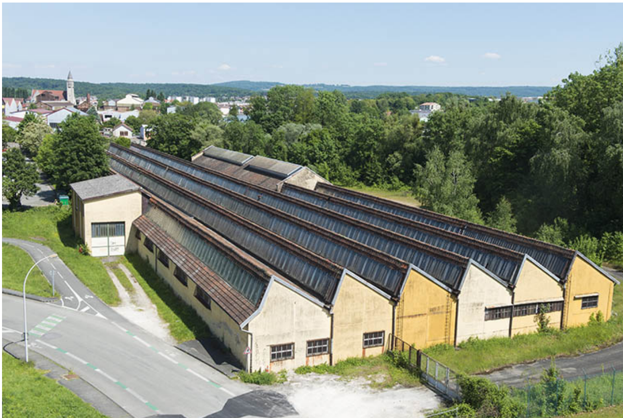
Vue plongeante sur l'ancien atelier de tréfilerie.
