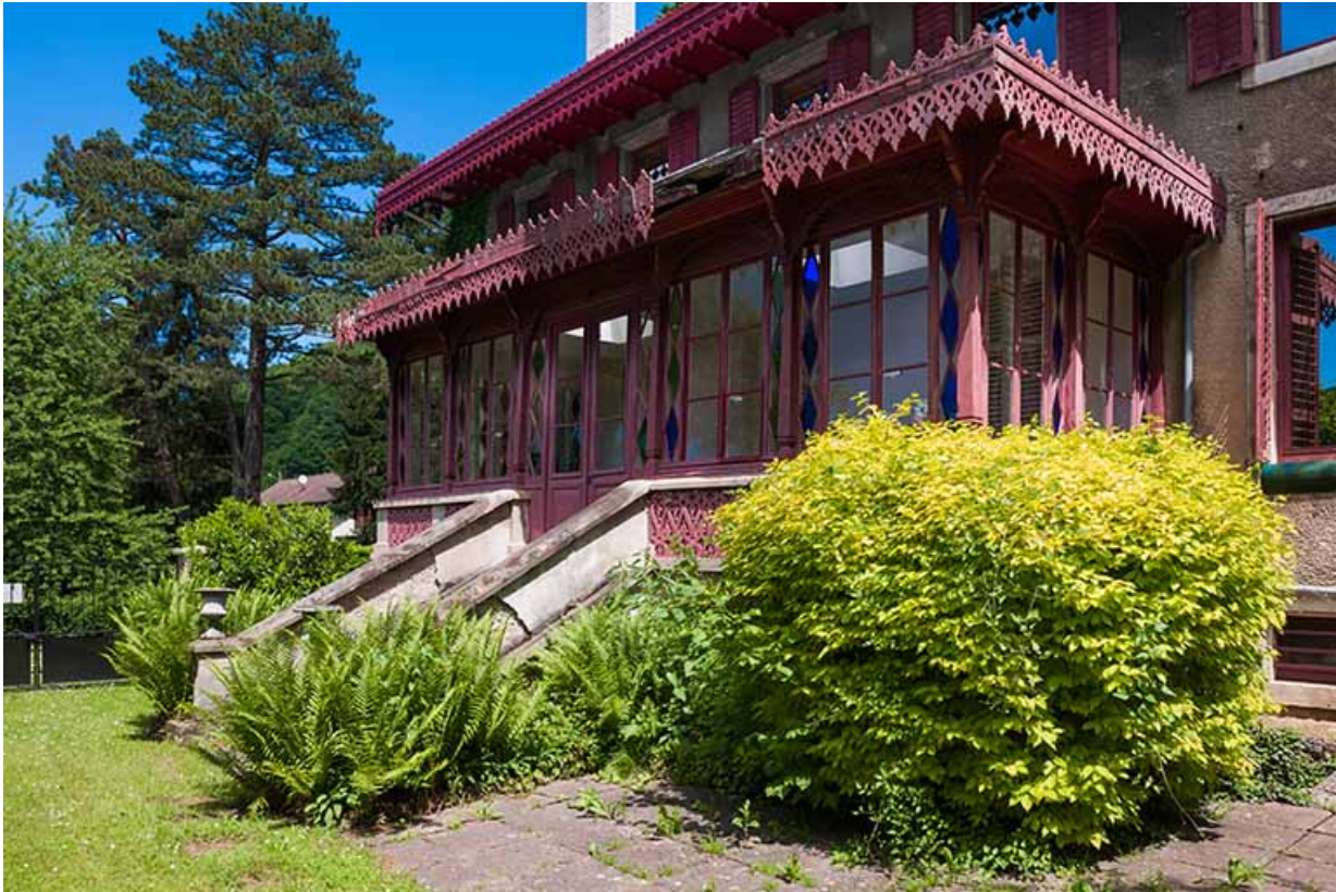
Véranda sur la façade ouest.
