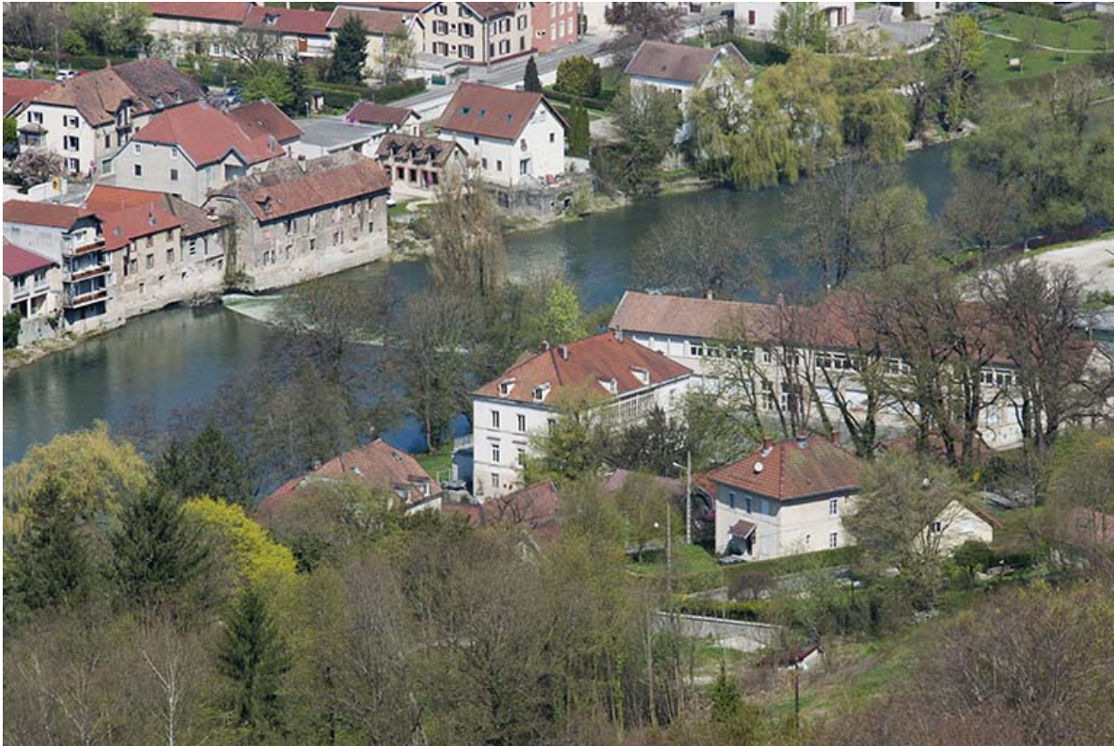
Vue d'ensemble plongeante depuis le sud-est.
