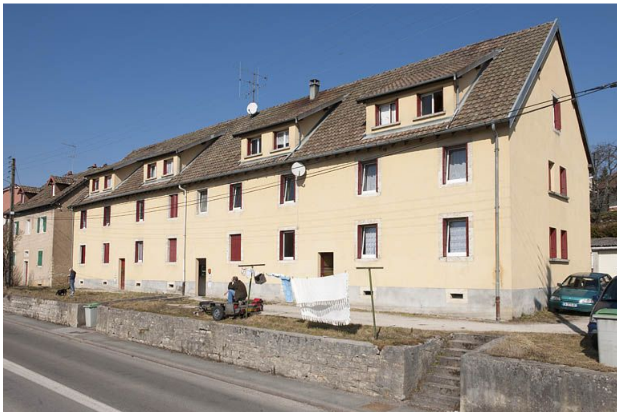
Immeuble d'habitation (10 logements).
