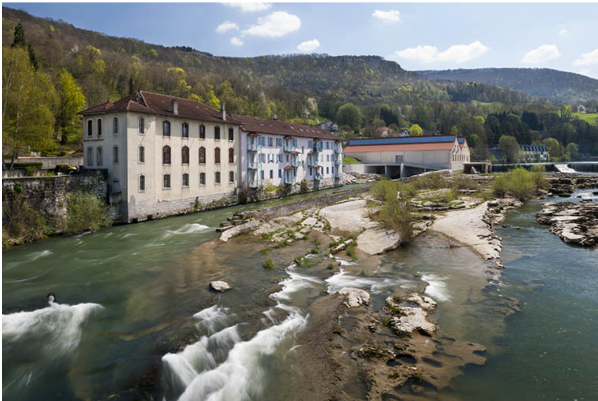
Usine rive droite depuis le pont.
