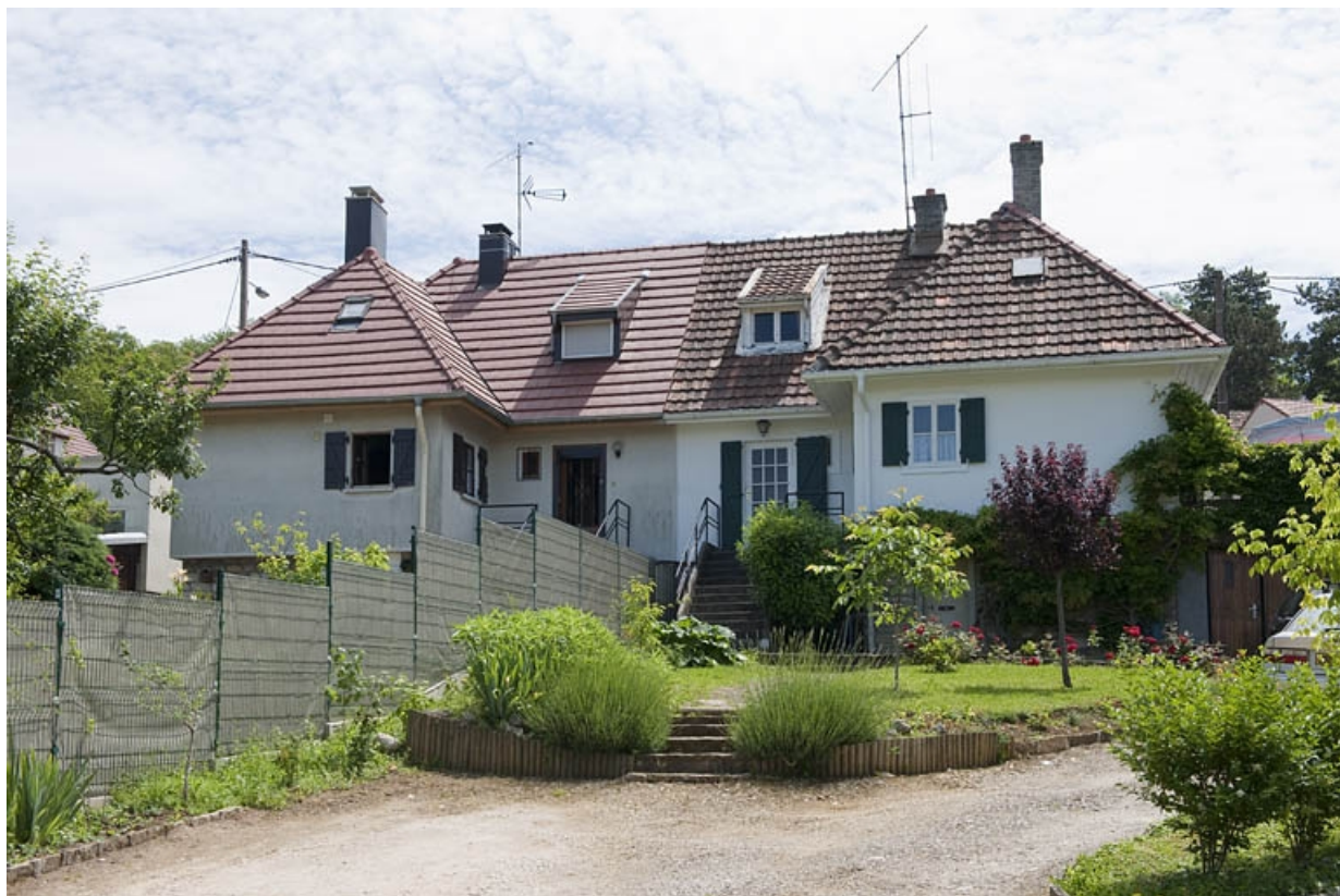
Maisons jumelles rue Raoul Delattre. Façades ouest.
