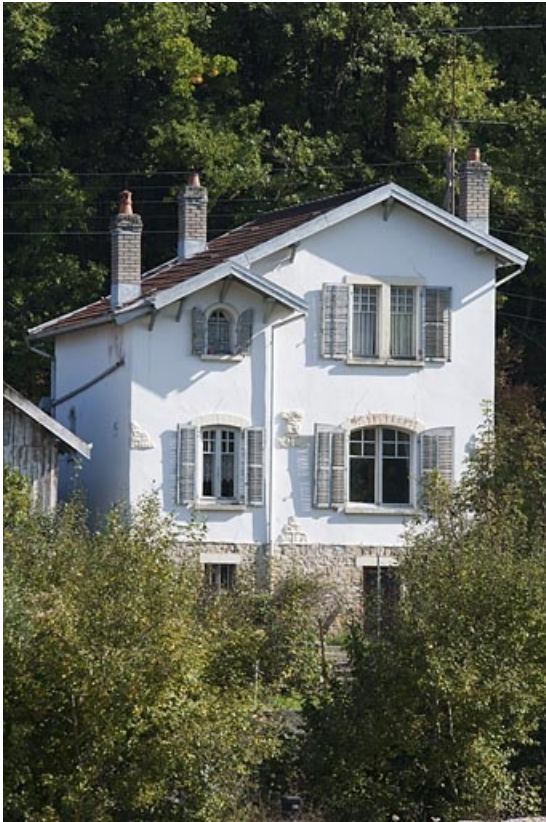
Pignon d'une maison individuelle.
