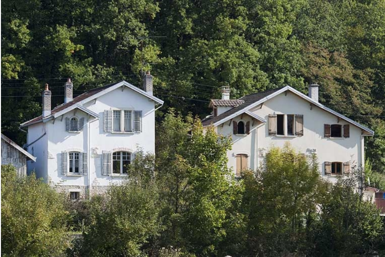
Maisons individuelles vues depuis l'ouest.
