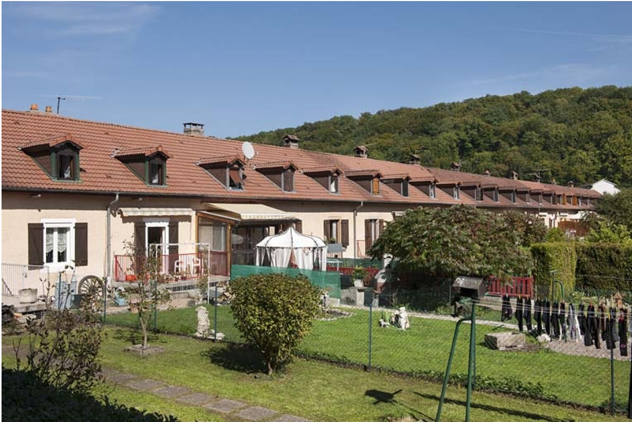
Caserne G. Façade postérieure depuis le sud-ouest.
