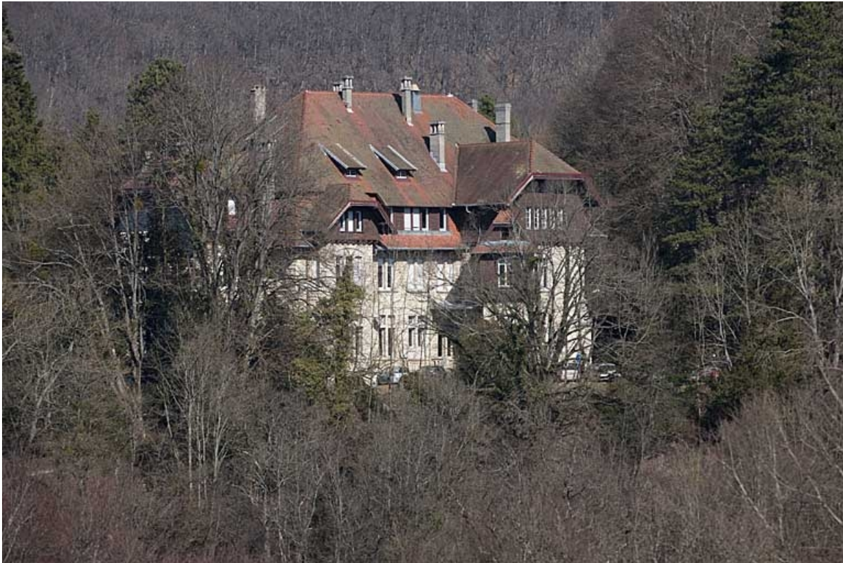
Vue éloignée depuis le sud-ouest.
