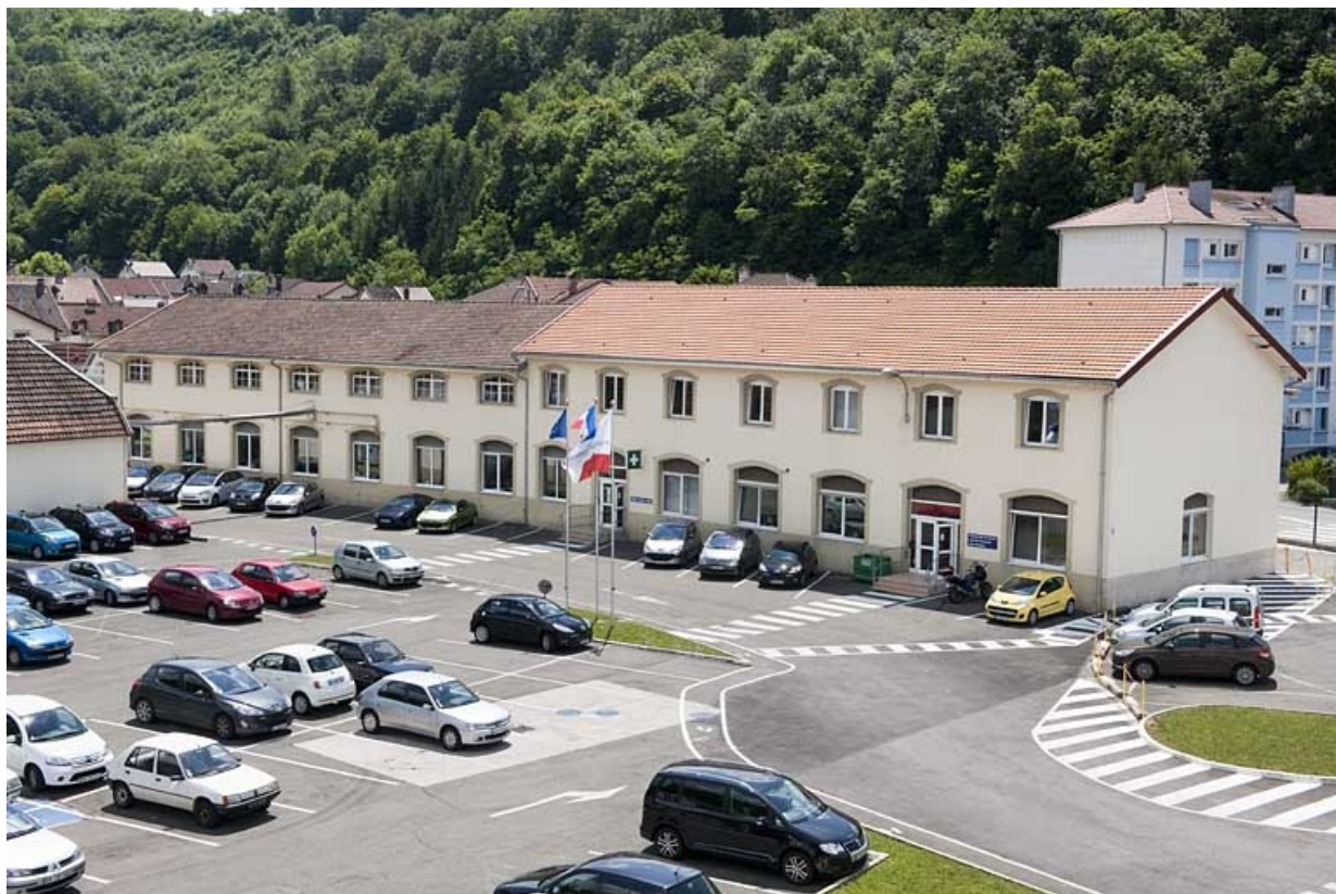
Bâtiment des bureaux depuis le nord-est.
