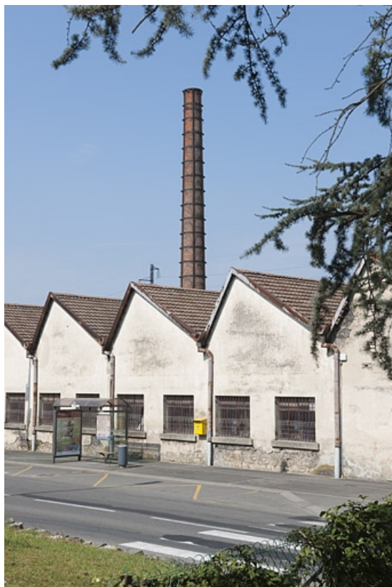
Vue rapprochée de l'atelier de laitonnerie.
