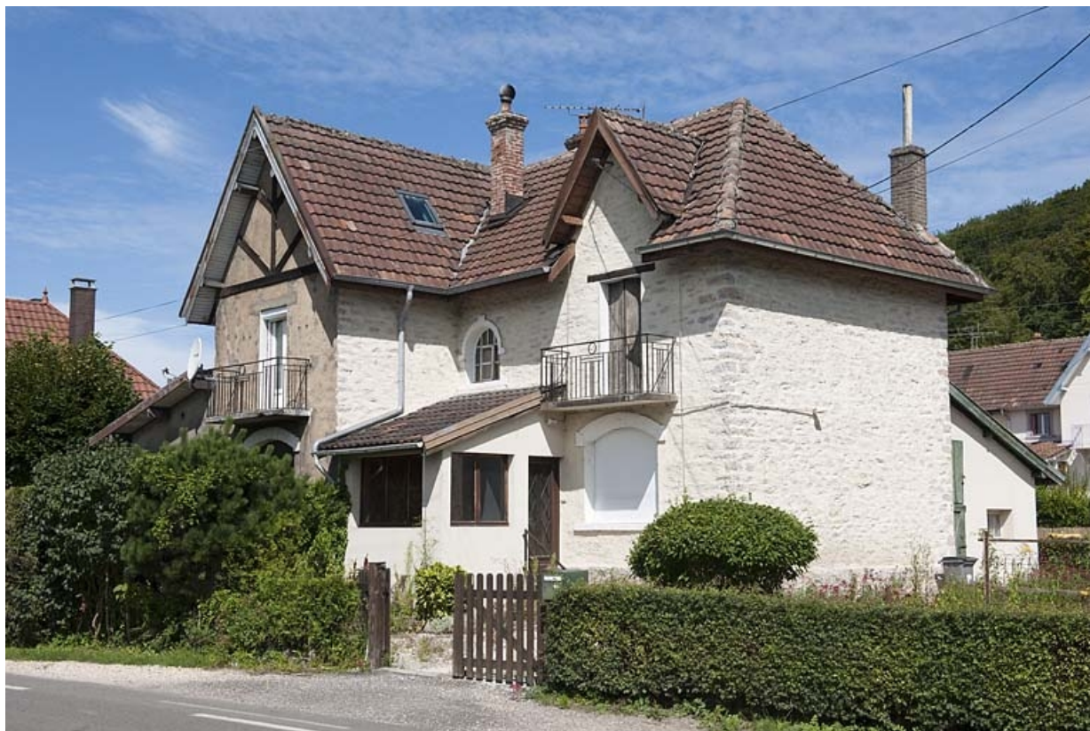
Maison de contremaîtres vue de trois quarts.
