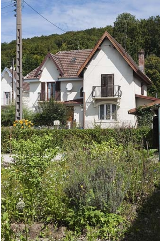
Maison de contremaîtres (n°4-6).
