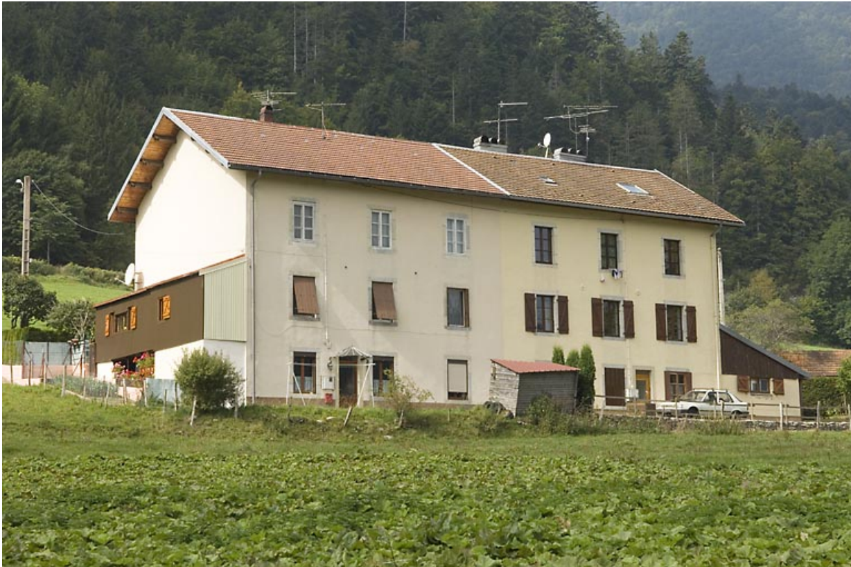
Immeuble à logements, façade postérieure.
