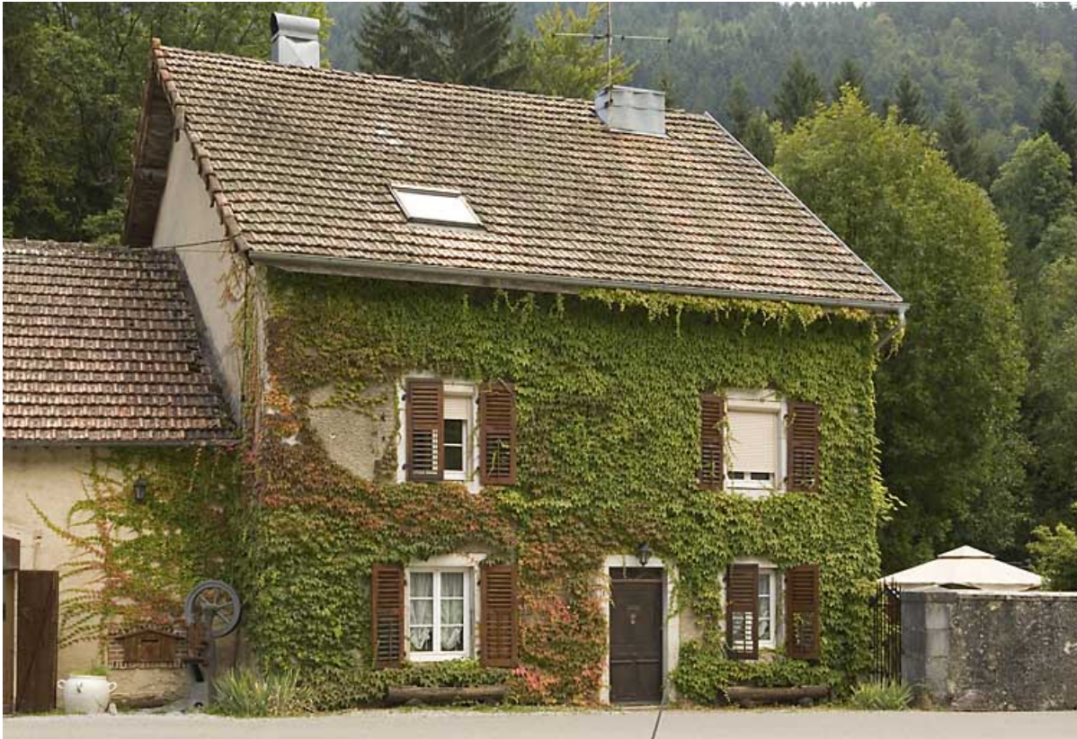
Maison : façade antérieure.
