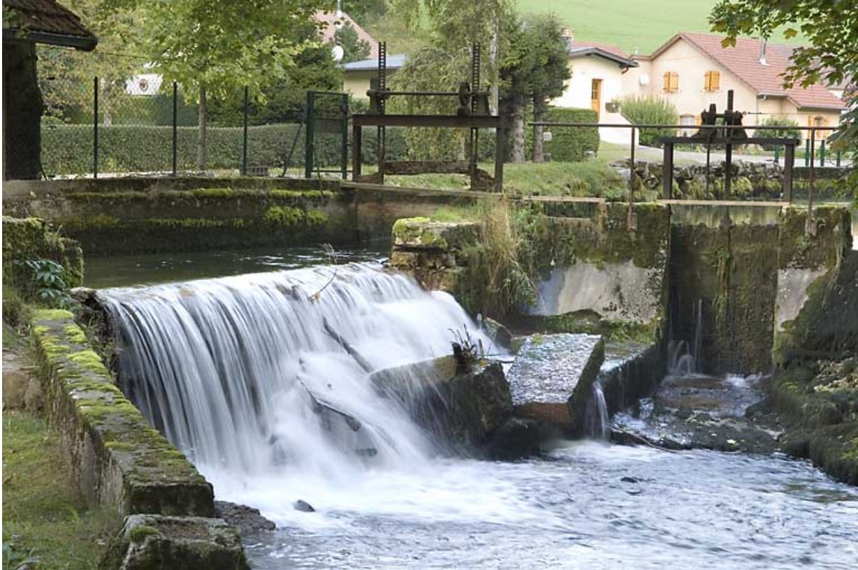
Canal d'amenée : vannes et déversoir.
