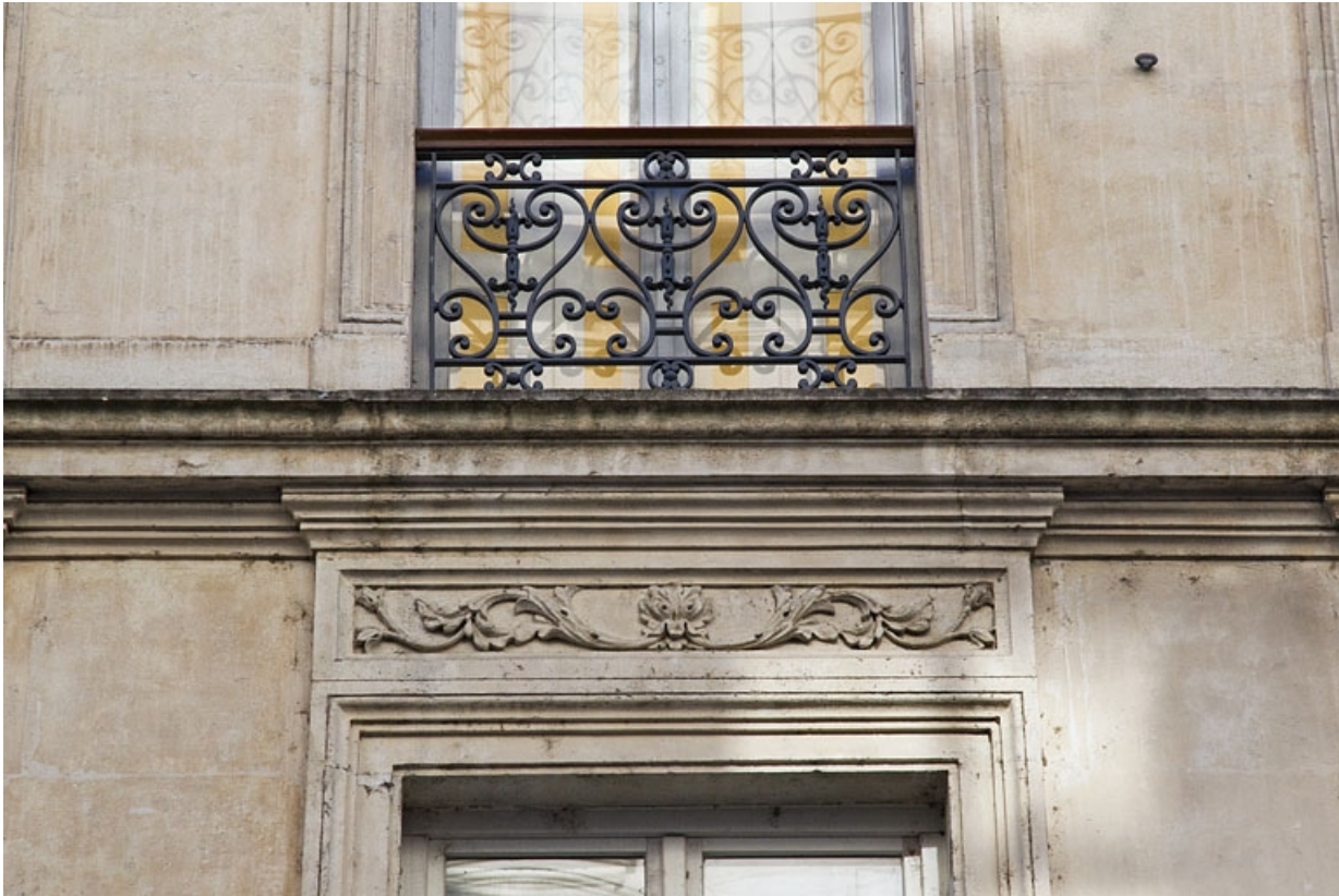
Façade antérieure : détail d'un garde-corps d'une fenêtre.
